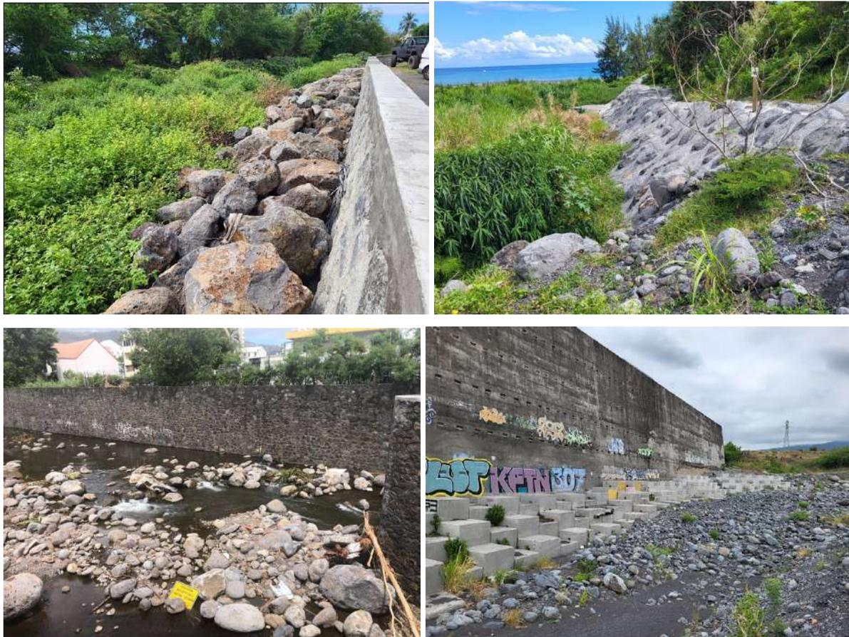
Figure 6 : Ouvrages de protection contre les inondations [a] enrochements libres, ravine Ermitage ; [b] enrochements liaisonnés, rivière des Remparts ; [c] murs maçonnés, ravine du Butor ; [d] déflecteur en béton armé, rivière des Galets. © André Evette
