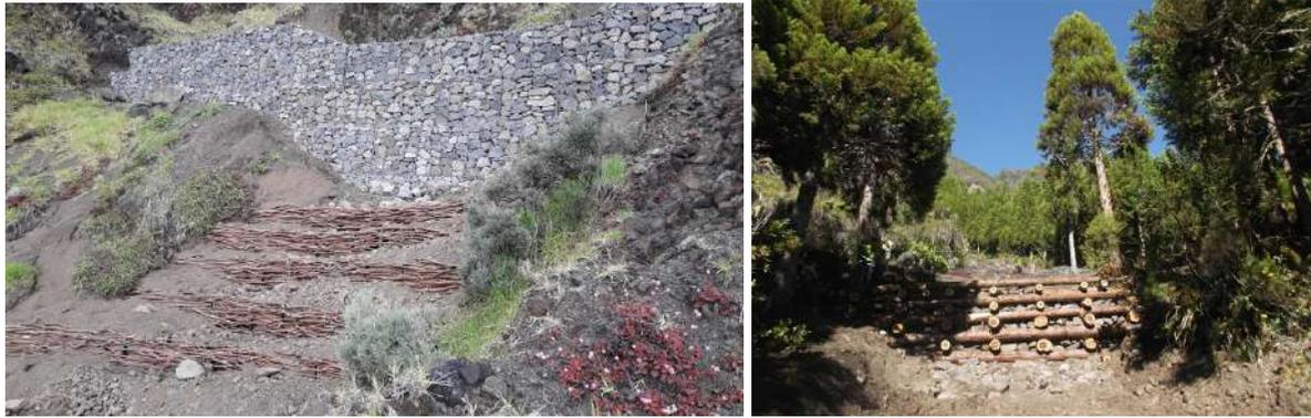
Figures 18 : [a] Chantier de lutte contre l'érosion de la ravine des Merles; [b] seuil "RTM Augustin Payet". ©ONF
