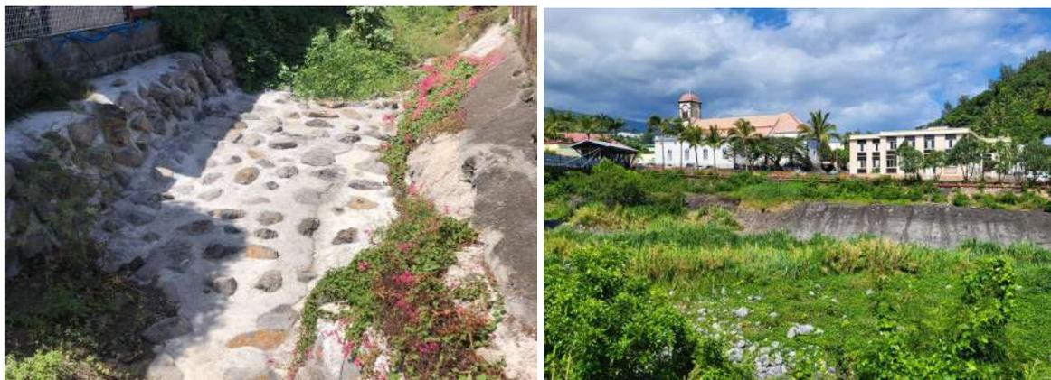
Figure 17 : Enrochements liaisonnés envahis par des espèces exotiques. [a] Saint-Gilles; [b] Rivière des Remparts. © André Evette
